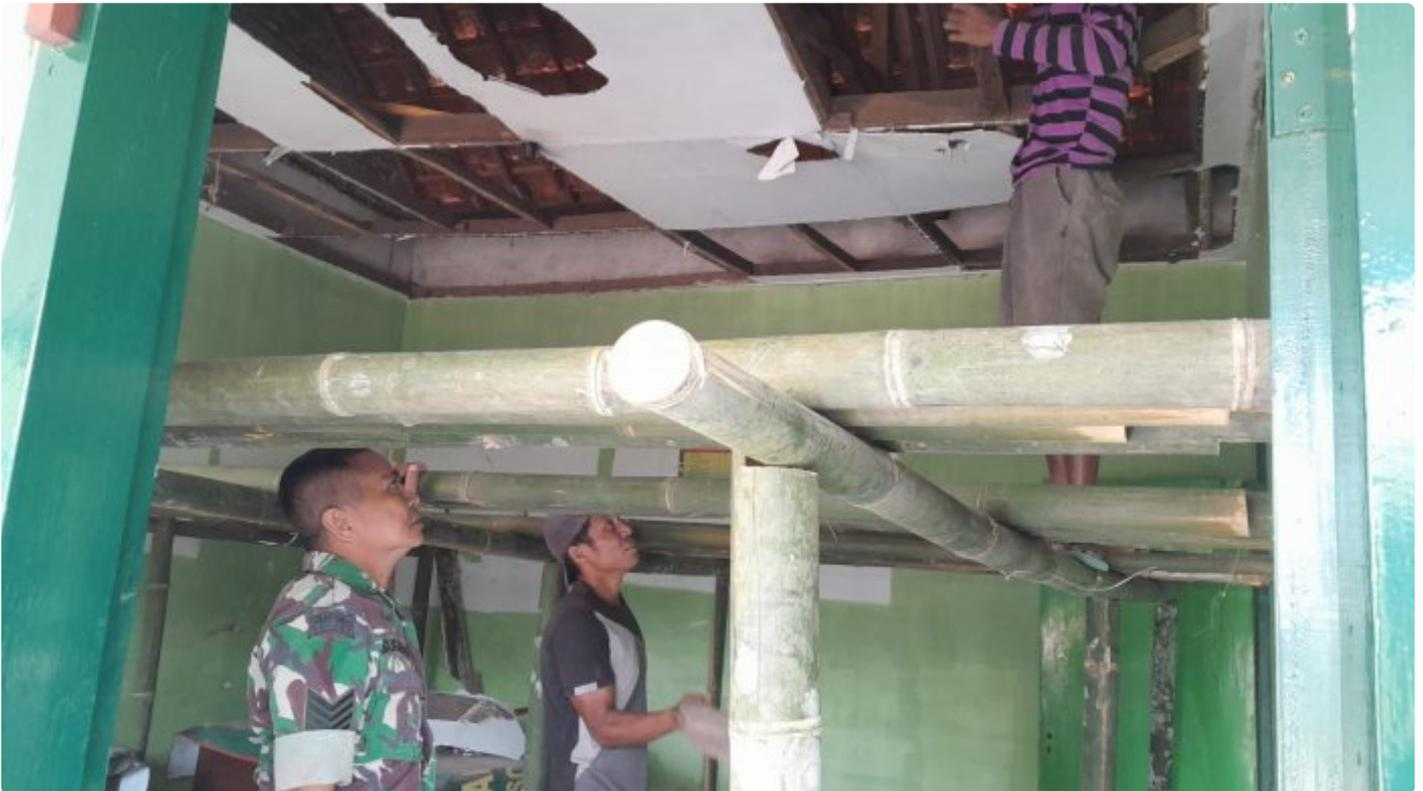
JEMBER – Perkembangan renovasi Makoramil 0824/14 Panti pasca penambahan tinggi tembok setinggi 50 Cm, pemasangan kuda-kuda dan kerangka atap yang terdiri dari kayu baru, pemasangan genteng baru sudah selesai, kini pekerjaan merambah ke bagian dalam bangunan, yaitu pengerjaan plafon.
